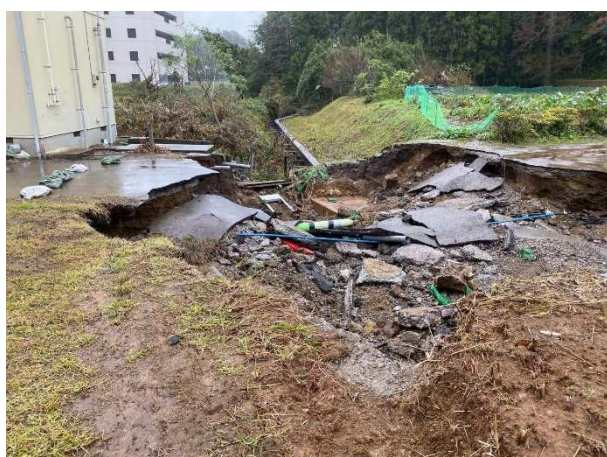
（大雨の影響で崩壊した現場・浄化槽が埋没の様子）
