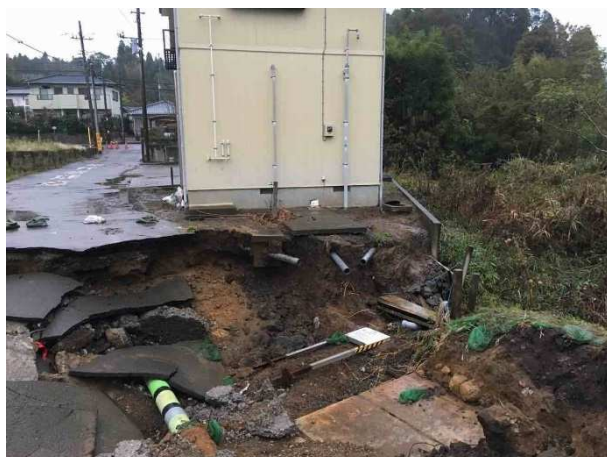
（大雨の影響で崩壊した現場・浄化槽が埋没の様子）
